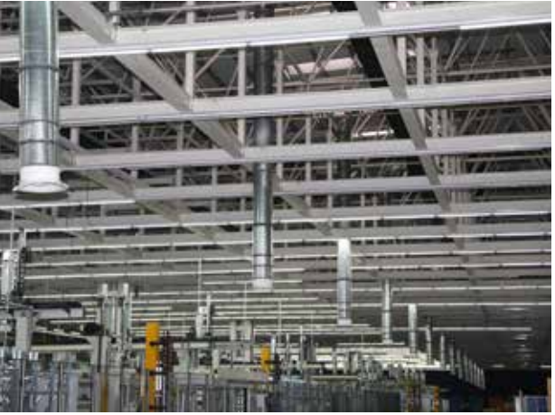
环保工厂——乳化液净化再利用
