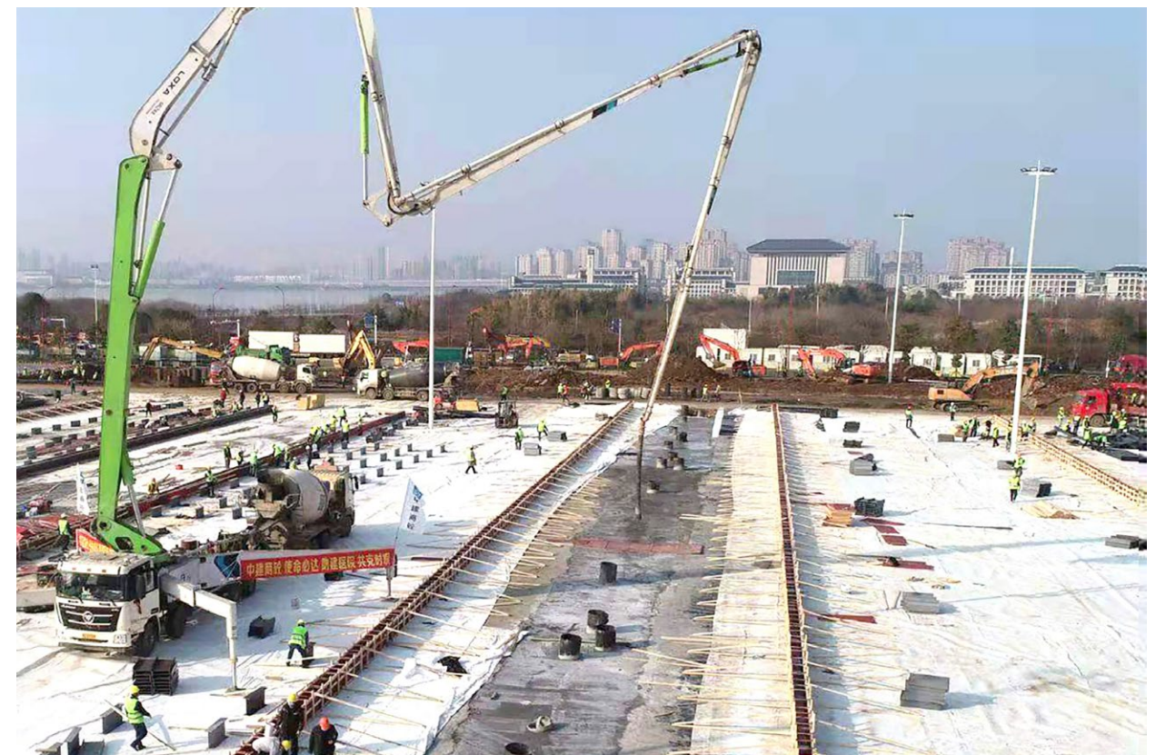
北汽福田雷萨泵车在武汉火神山医院施工现场作业
