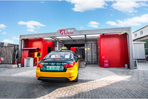
出租车驶入 4.0 换电站
